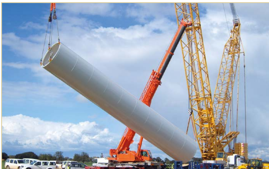
Figura 9. Construcción de parque eólico
