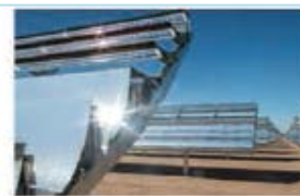
Centrale pilote PV à faible concentration (25Kw)
