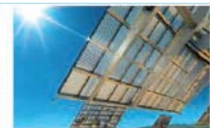
Centrale pilote PV à haute concentration (25Kw)
