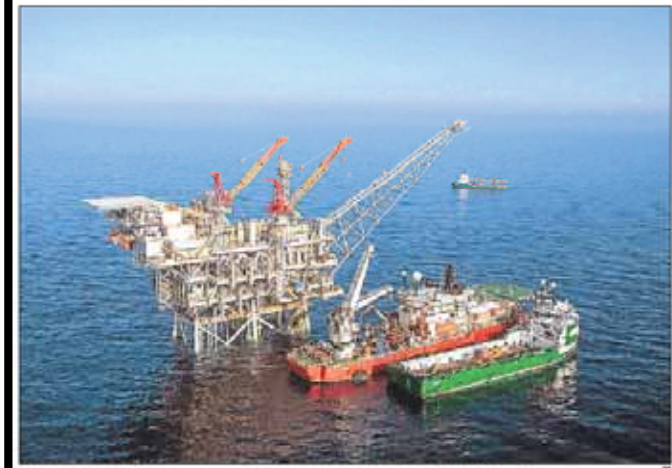
La planta de extracción de gas Tamar, a sesenta kilómetros de la costa israelí, frente a la ciudad de Haifa.
