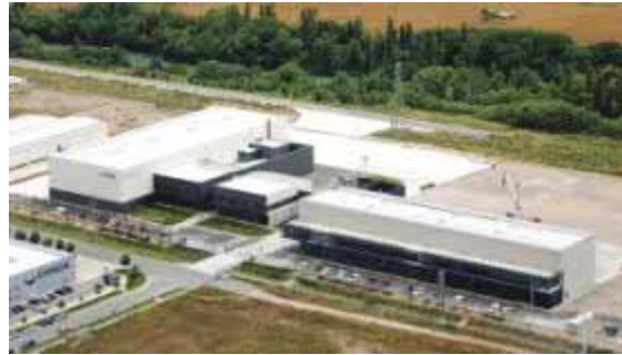
Laboratorio de Ensayo de Aerogeneradores Sangüesa
